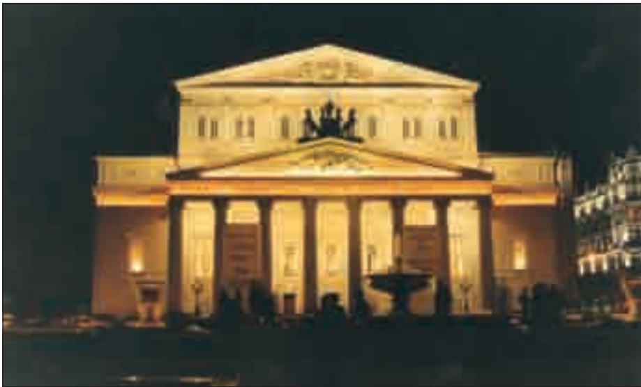
Рис. 4. Отсутствие на фасаде Большого театра равномерного заливающего освещения приводит к резкому световому контрасту между освещенным внутренним объемом парадного портика и внешней стороной несущих колон, а также между ярким световым поясом антаблемента и недосвеченными боковыми крыльями фасада, при этом совершенно не читается цилиндрическая форма колонн
