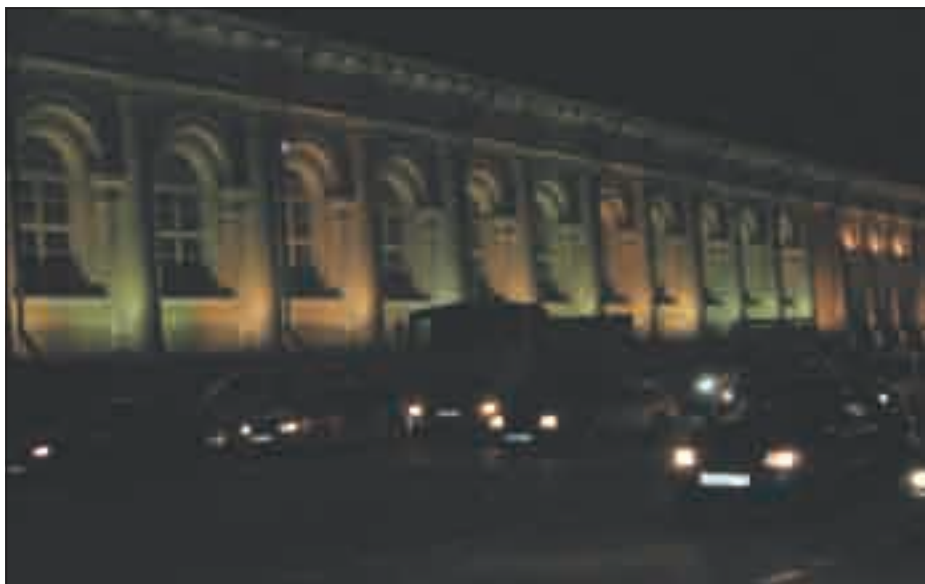
Рис. 5. Освещение восстановленного после пожара здания Манежа
