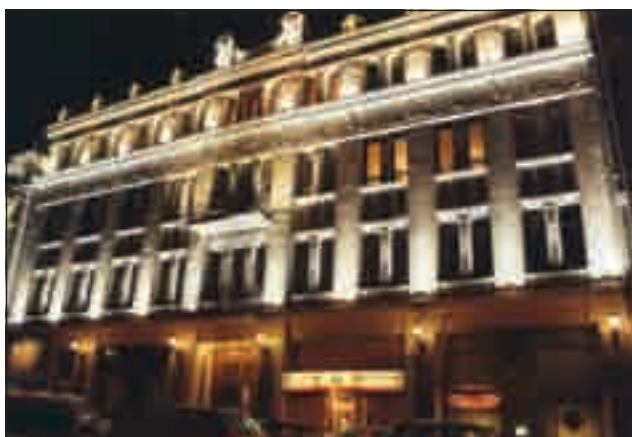
Рис. 6. Короткие кронштейны не позволили прорисовать светом пластическую «изюминку» фасада – барельефный фриз в этом, в целом удачном световом решении. Часто встречающаяся конструктивно-светотехническая ошибка – недостаточный вынос ОП
