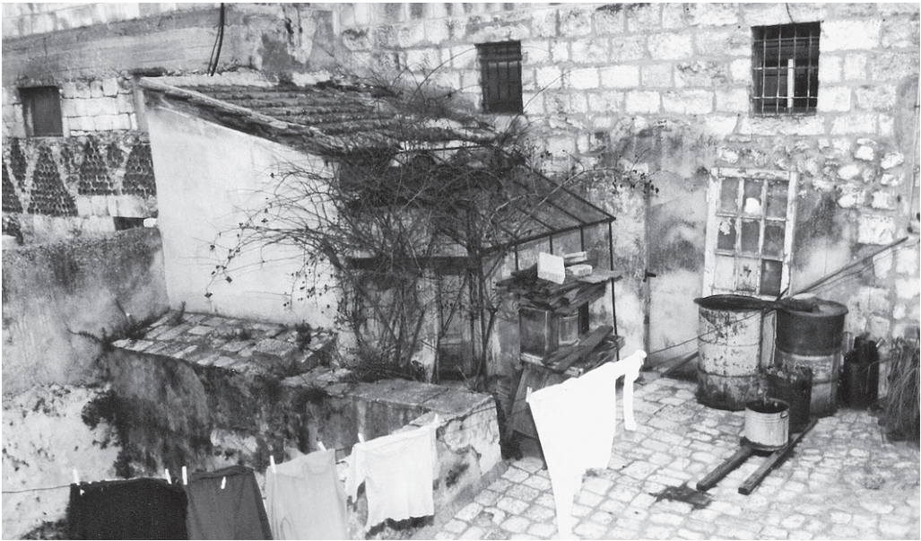
70 Innenhof im Johanniter-Hospiz vor der Renovierung
